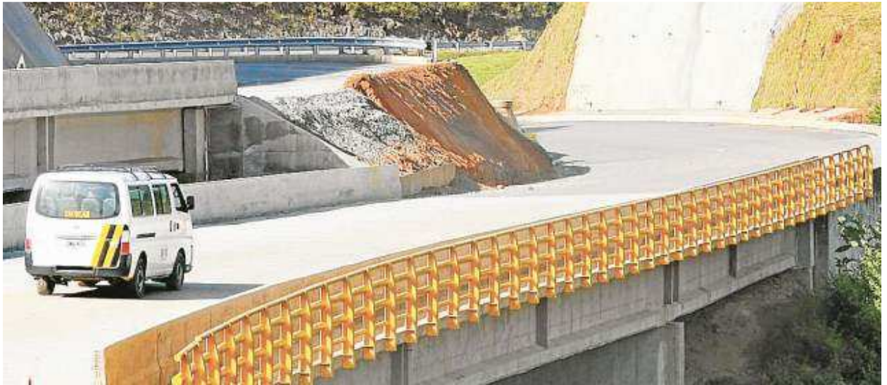
Una de las vías proyectada es a Puerto Berrío. En la imagen, doble calzada Hatillo-Barbosa. FOTO JUAN A. SÁNCHEZ
